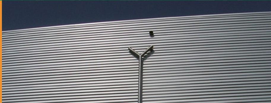
Das Sandwichelement mit gewellter Außendeckschale und einer Fugengeometrie für verdeckte Befestigung lässt Fassaden durch das Licht-Schattenspiel des Wellprofils, sehr lebendig erscheinen. Die hochdämmende Eigenschaft des FCKW- und HFCKW-freien Polyurethan-Dämmkerns erfüllt bei weitem die heutigen Anforderungen an den Wärme- und Feuchteschutz. Ein im Längsstoß angeschäumtes, unverrutschbares Dichtband schließt die Fuge schlagregen- und winddicht ab. Eine werkseitig
