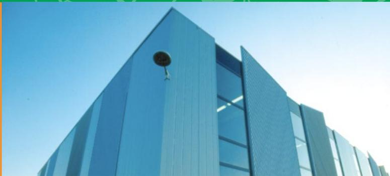
Das Sandwichelement mit Polyurethan-Dämmkern, zur vertikalen und horizontalen Montage bestens geeignet, erleichtert mit seiner speziellen Oberflächenprofilierung erheblich die „beulenfreie“ Montage. Das optische Erscheinungsbild wird durch den in der Vertiefung sitzenden Schraubenkopf erheblich begünstigt. Ein im Längsstoß angeschäumtes, unverrutschbares Dichtungsband schließt die Fuge schlagregen- und winddicht ab. Die organische Kunststoffbeschichtung der metallischen Deckschalen garantiert
